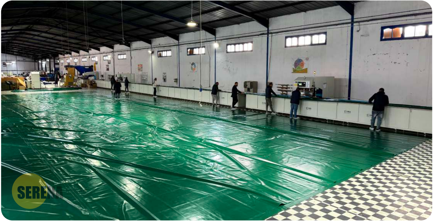
Fabrication d'une citerne de 1000 m 3
